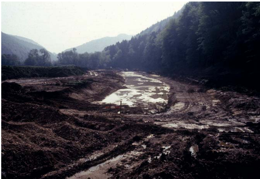
1983—1984 travaux de déplacement de la Birse près de Soyhières dans le cadre d'un vaste projet d'amélioration des infrastructures
