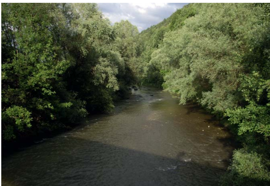
2011 état de la rivière, 27 ans après les travaux, montrant un cours d'eau qui ne laisse pas voir qu'il a été créé de toute pièce
